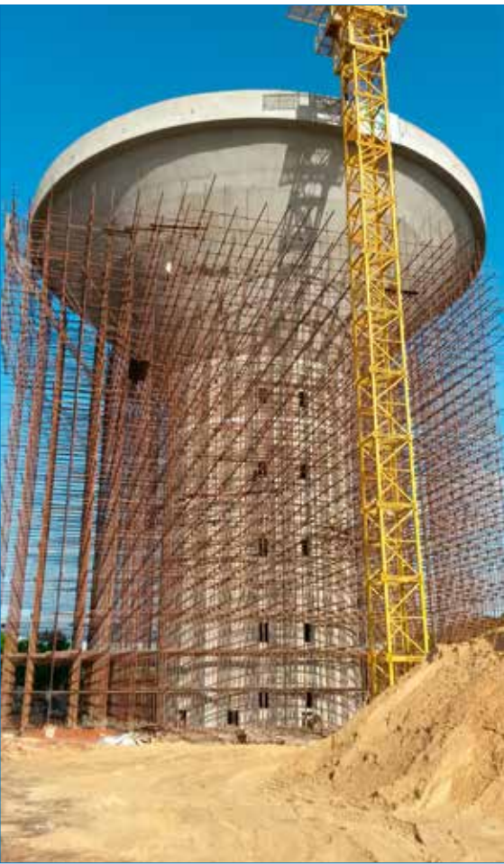
◀ Torre de água de 3 200 m 3 em Zinguinchor, Senegal
