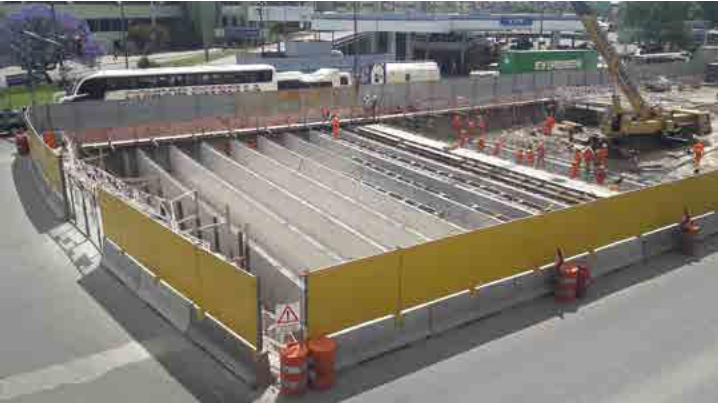
Paseo del Bajo Project
