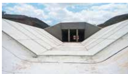
Cinturão de Águas do Ceará Hydraulic Project - Lot 1 / Brazil
