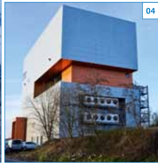
Arquitecto - R2D2, Foto: J.L. Rodríguez Samper
