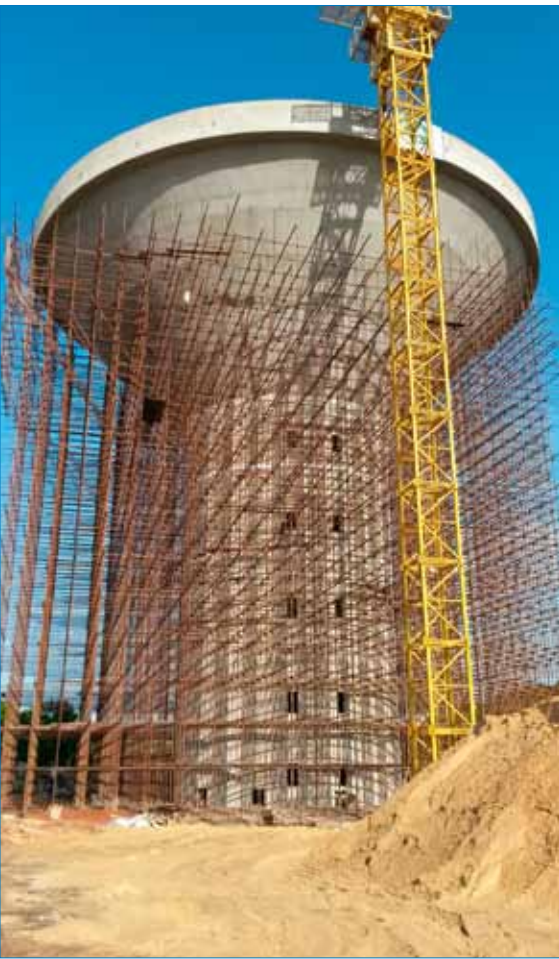
◀ Torre de agua de 3.200 m³ en Ziguinchor, Senegal
